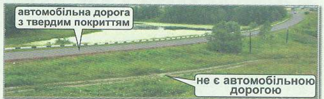
Рис. 1.2. Загальний вигляд накатаної дороги
